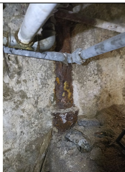
Pohled na stávající stoupací potrubí S4
